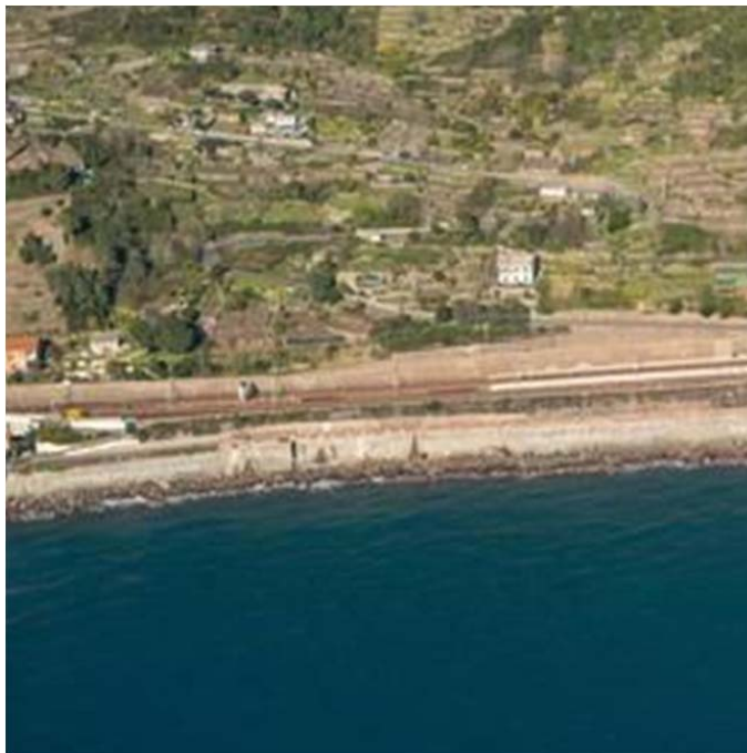
Figura 24: Zona di Corniglia, muraglione della Ferrovia sul mare
