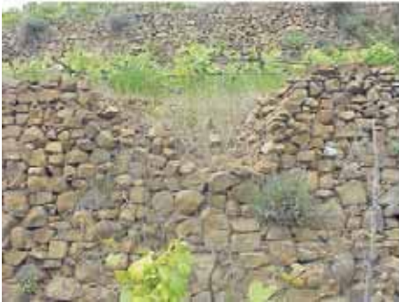
Esempi di crollo degli elementi nella parte sommitale del muro.
