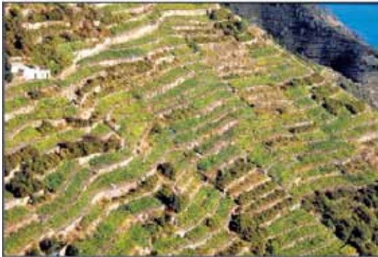
Sistemazione del versante con muri in pietra secca a filo del piano d'uso nella zona di Costa di Corniolo.
