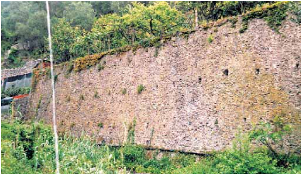
Esempio di muro di contenimento a calce nella zona di Monterosso.
