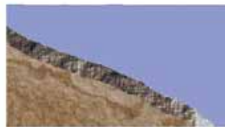
Preparazione del piano di posa del muro a valle
