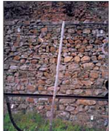
Sistemazione del versante con muri in pietra secca a filo del piano d'uso nella zona di Costa di Corniolo.
