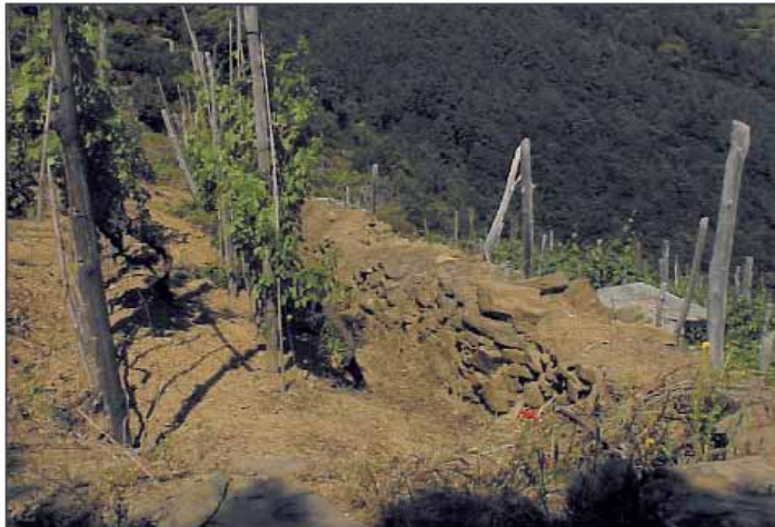
Particolare di sistemazione del versante con muri a secco con la testa del muro rialzata nella zona di Schiara.
