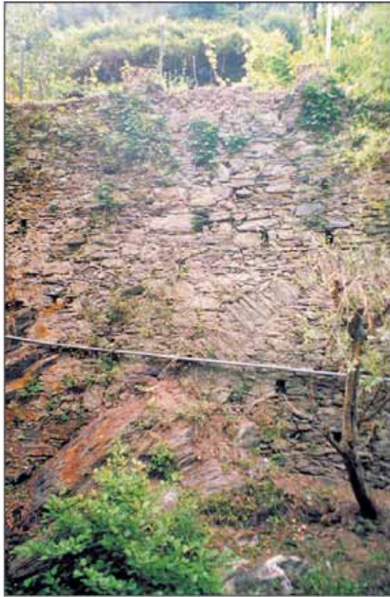
Particolare di muro di contenimento a calce nella zona di Monterosso.
