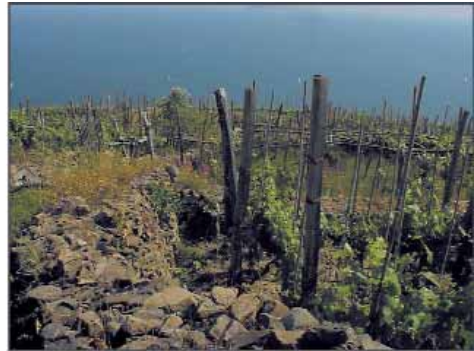
Esempi di sistemazione del versante con muri a secco con la testa del muro rialzata nella zona di Schiara.
