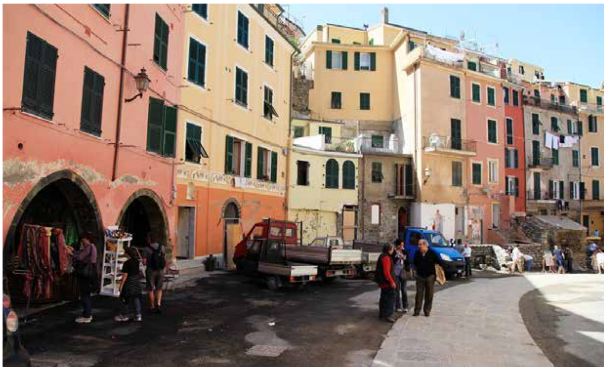
Figura 22. Via Roma in attesa dell'intervento
