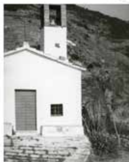
Chiesa degli Angeli Custodi - Fossola di Tramonti
