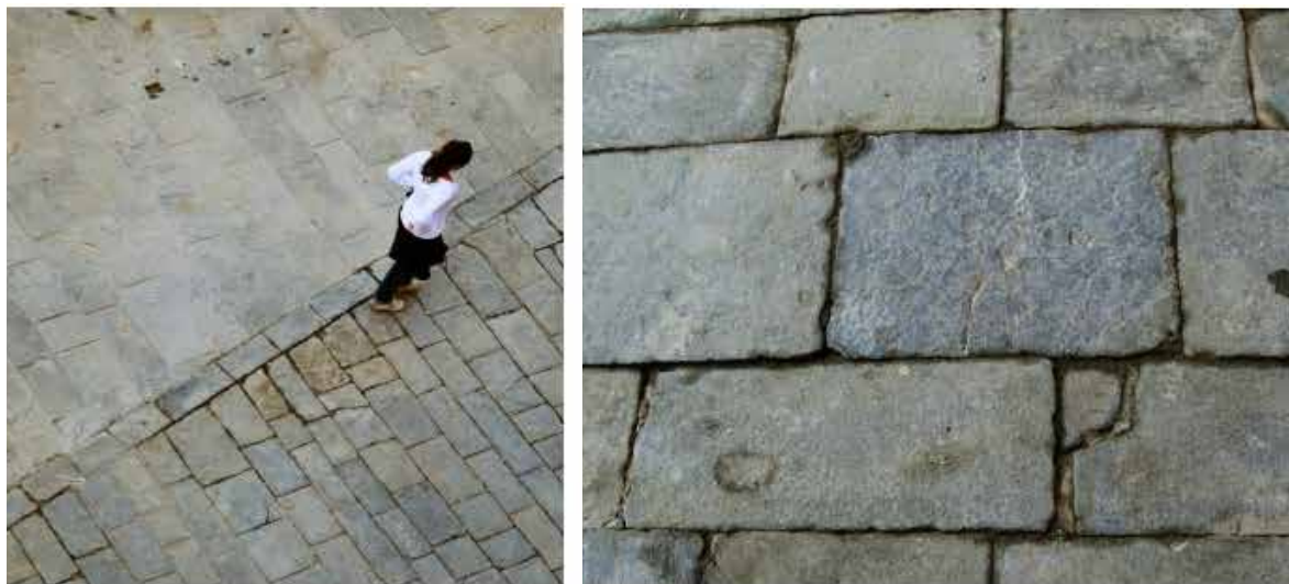
Figura 27. Stato delle pavimentazioni prima dell'intervento
