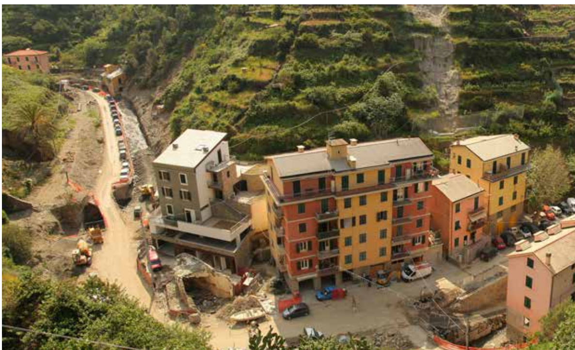
Figura 25. Il parcheggio dopo la pulizia post alluvione
