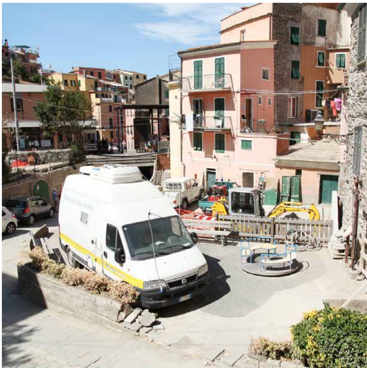
Figura 23. Piazza Caduti della Libertà in attesa dell'intervento
