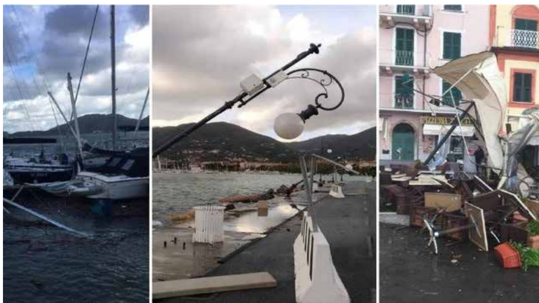
Figura 17. Alcuni dei danneggiamenti causati dalla mareggiata del 2018
