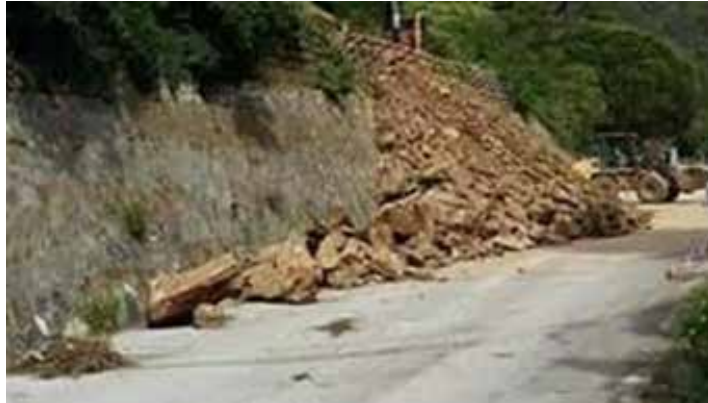
Figura 13. Esempi di danneggiamenti causati dalla frana del 2016
