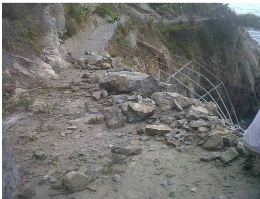
Figura 18. Frana sulla Via dell'Amore
