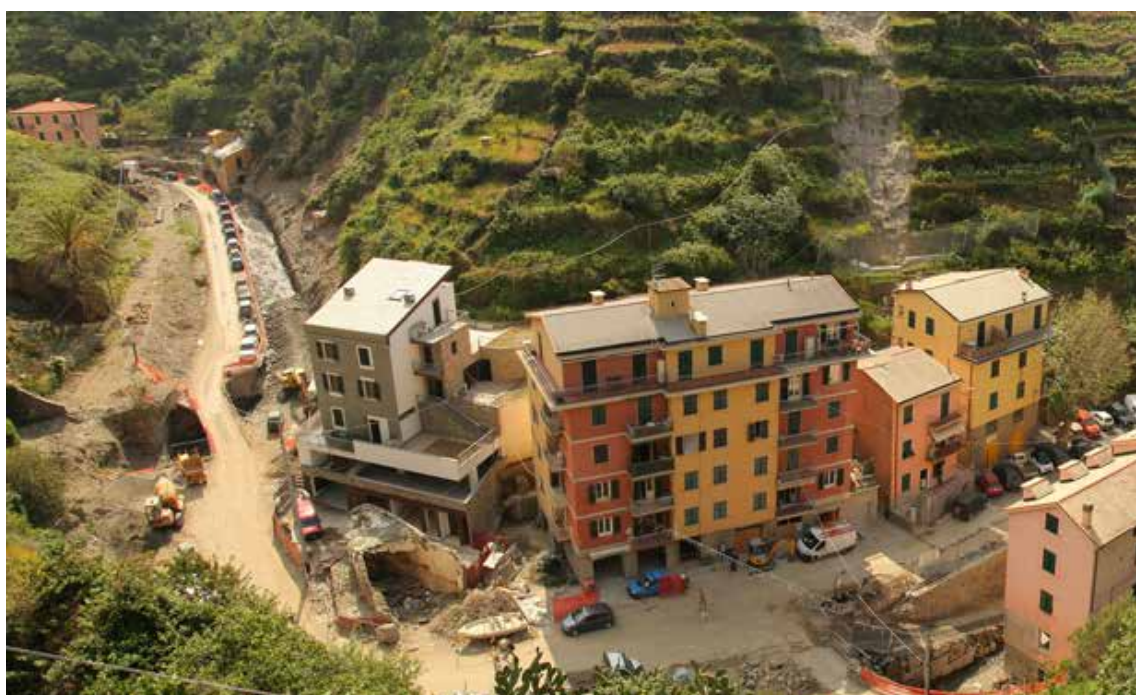
Figura 25. Il parcheggio dopo la pulizia post alluvione
