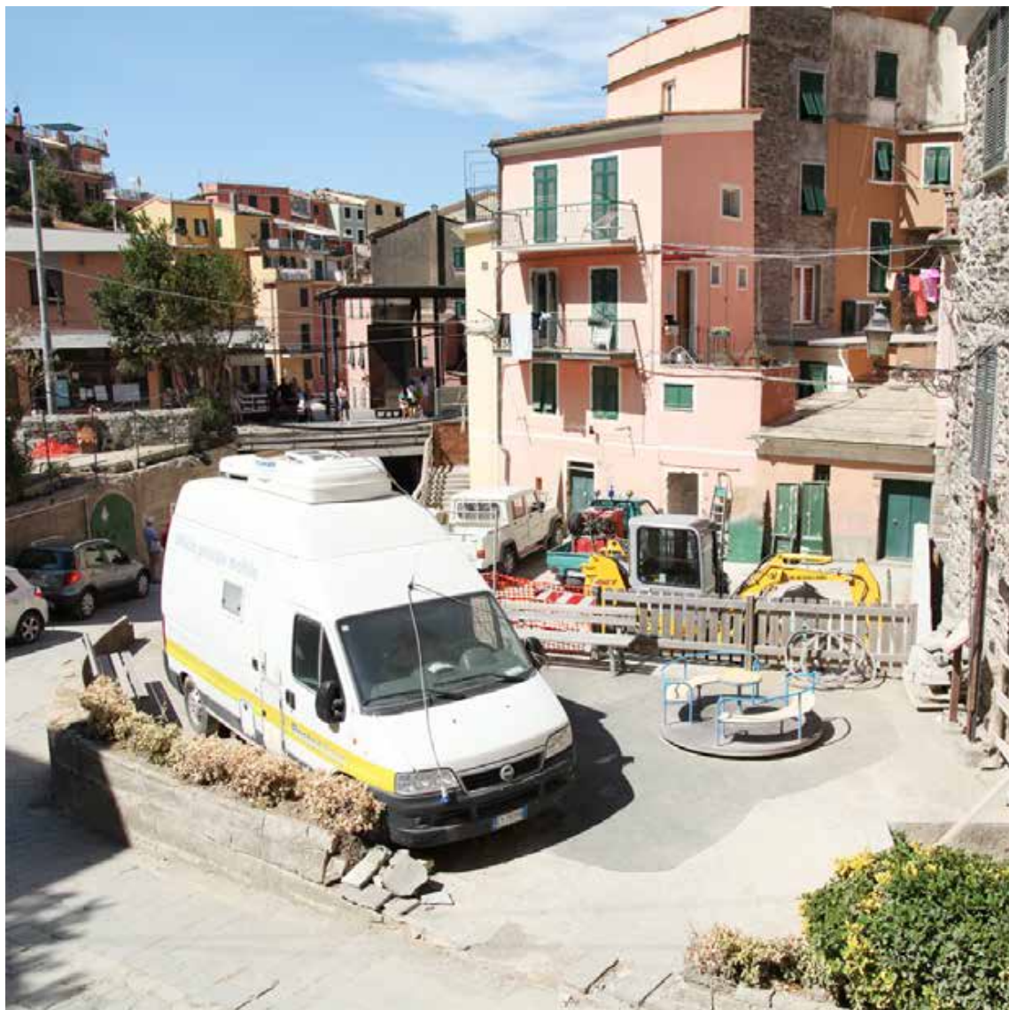
Figura 23. Piazza Caduti della Libertà in attesa dell'intervento
