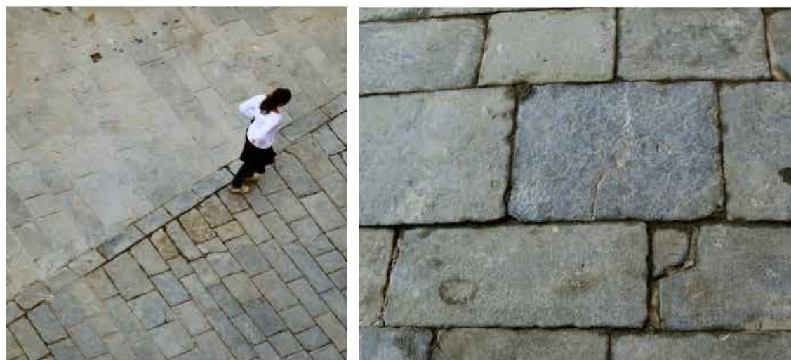
Figura 27. Stato delle pavimentazioni prima dell'intervento
